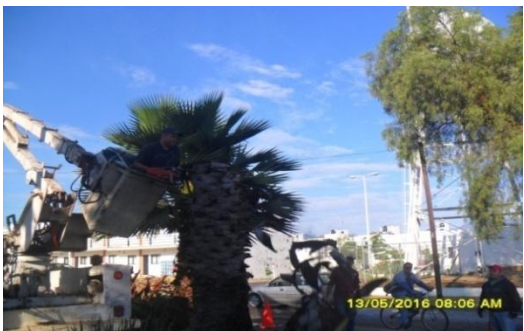
DERRIBO EN ABASOLO ESQ. FRAY PEDRO DE GANTE
