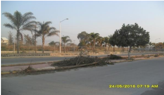
RETIRO DE ARBOL. COLAPSADO DE LA AV. RAFAEL RAMIREZ
