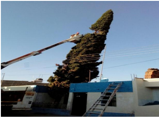
DERRIBO DE CIPRES EN LA COL. VILLAS DEL NEVADO
