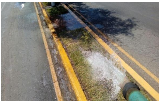
RIEGO DE CAMELLONES CON PIPA
