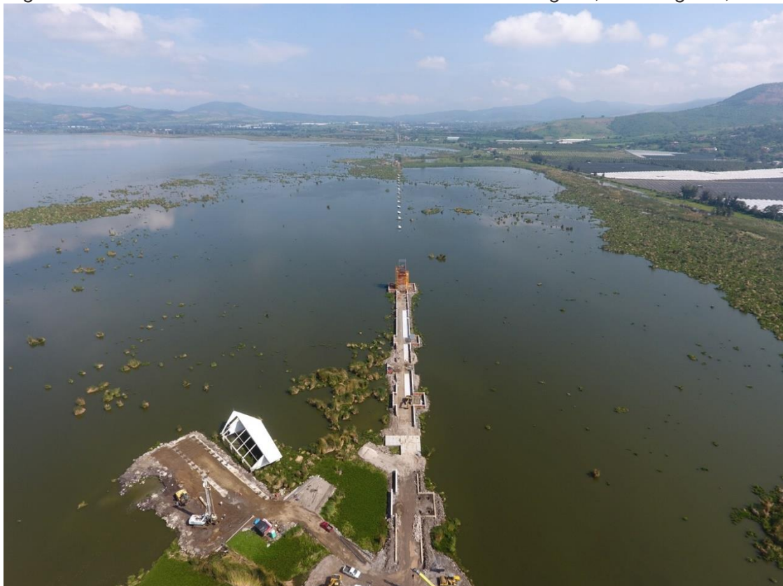
Figura 43. Construcción del muelle e infraestructura en la laguna, 19 de agosto, 2021
