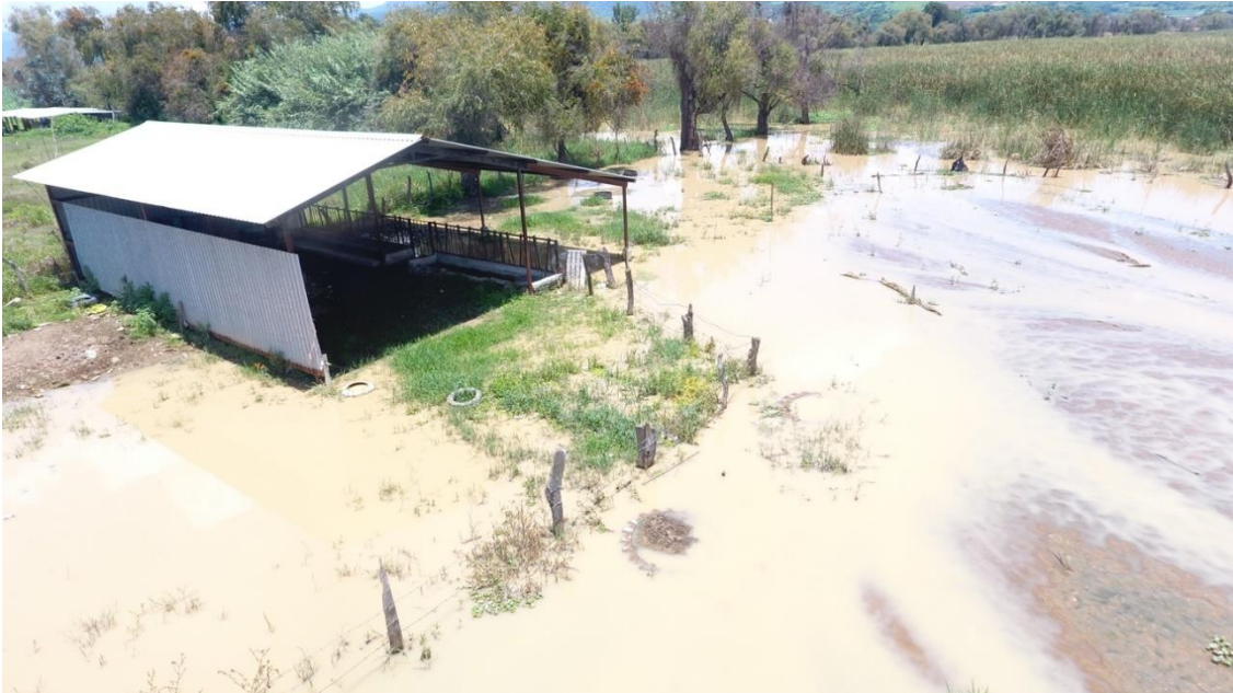
Figura 42. Corrales inundados en la zona federal de la laguna, 19 de agosto, 2021
