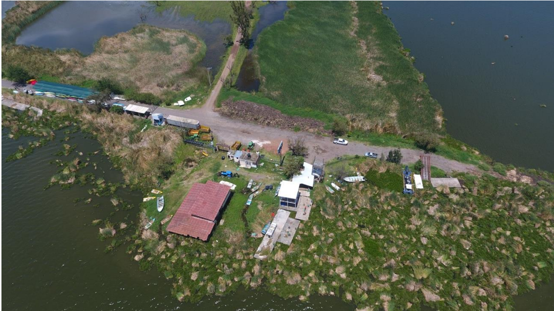
Figura 44. Rellenos e infraestructura en el contorno de la laguna, 19 de agosto, 2021
